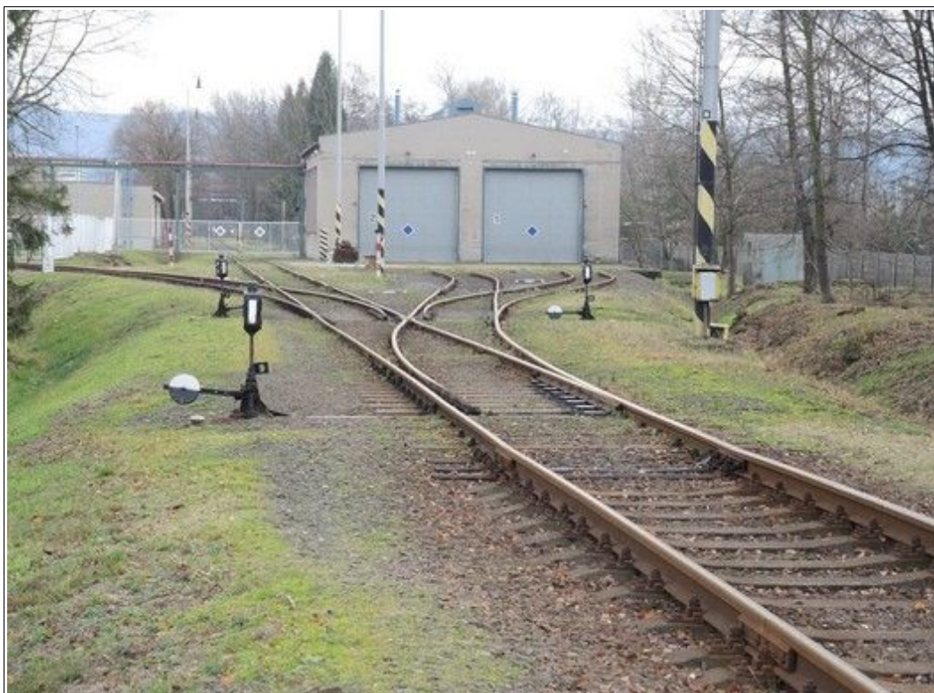
Obr. č. 6: Pohled na místo MU před výhybkou D9 a depo lokomotiv.
