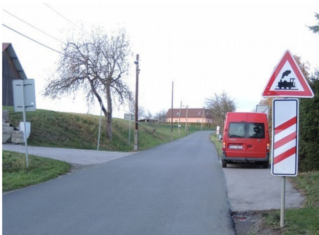
Obr. č. 4: Viditelnost značky Železniční přejezd bez závor a Návěstních desek (240m a 160 m)
