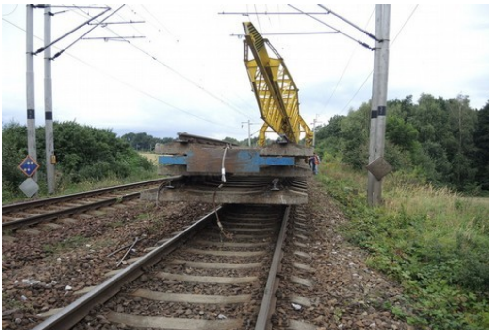
Obr. č. 5: Ukládání kolejových polí na podvozky vzor 53/77 pokladačem PKP 25/20
