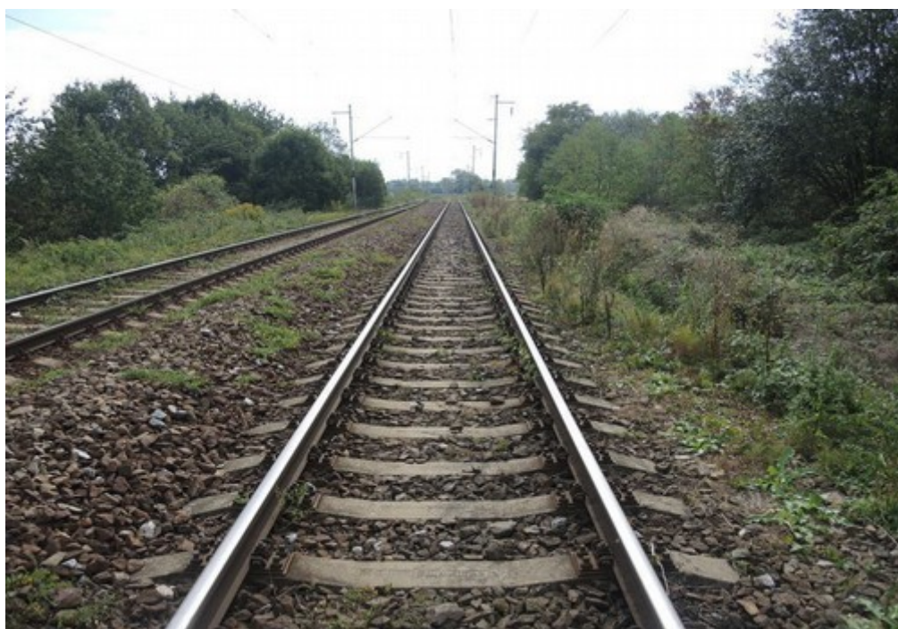
Obr. č. 8: Rozhled na trať z místa střetu s defektoskopisty, ve směru na Vlkaněč.
