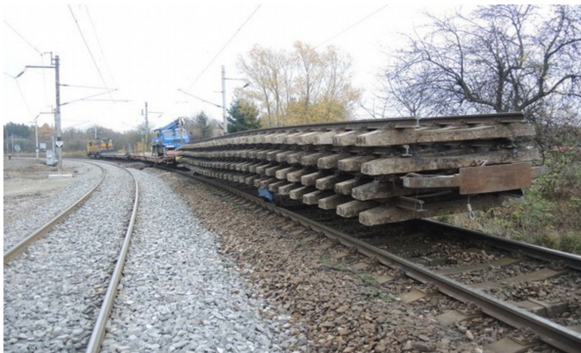
Obr. č. 12: Přistavení svazku kolejových polí k ověřovacímu pokusu
