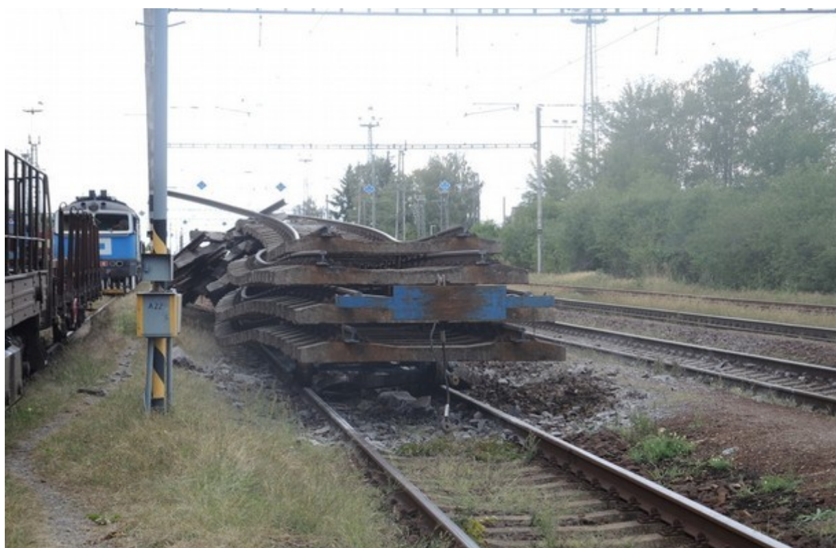
Obr. č. 10: Ujetý svazek kolejových polí, vklíněný do odstavených svazků na 3. SK žst. Golčův Jeníkov
