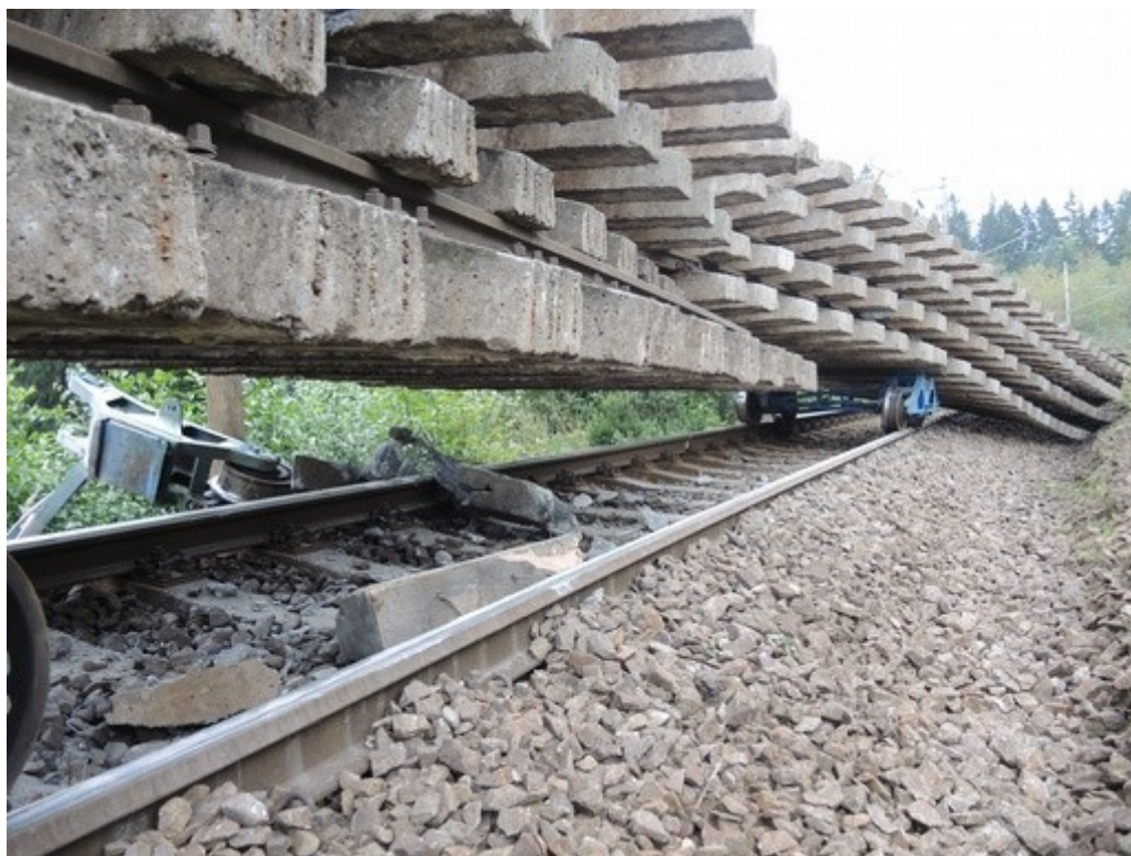
Obr. č. 9: sesunutý 5. svazek kolejových polí
