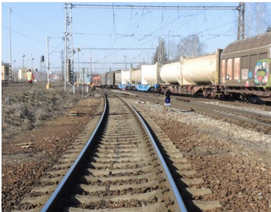
Obrázek 3: Pohled na návěstidlo Se7.
