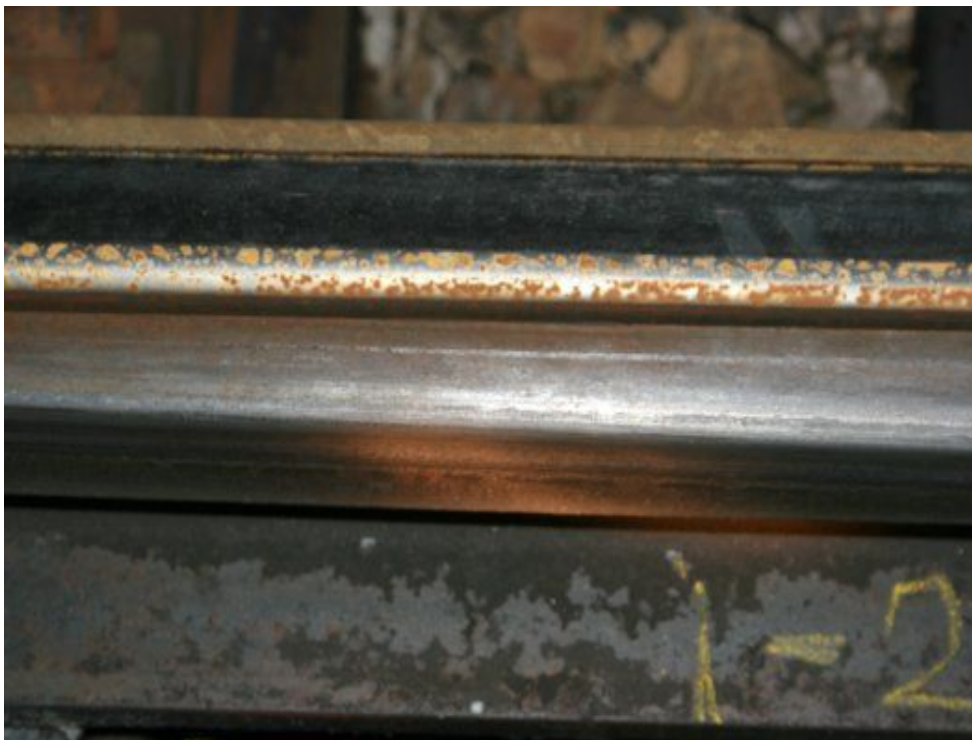
Obr. č. 5: Stopy po okolku na jazyku výhybky – 2 m za „bodem nula“
