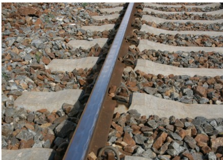
Obr. č. 7: Stopy po otěrech okolků kol na vnitřních kolejnicových pásech Zdroj: DI
