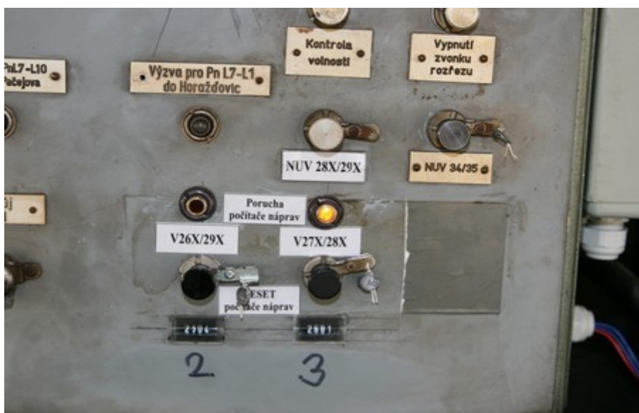
Obr. č. 16: Indikace poruchy počítačů náprav na indikační desce a tlačítko k nouzovému uvolnění úseků
