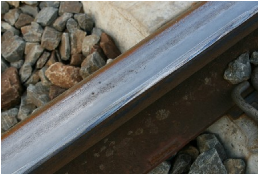
Obr. č. 8: Stopy po otěrech okolků kol na vnitřních kolejnicových pásech – detail
