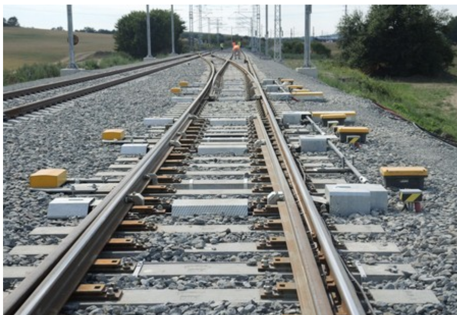
Obr. č. 3: Výhybka č. 27X přestavená do přímého směru a výhybka č. 28X přestavená do odbočného (vedlejšího) směru Zdroj: DI
