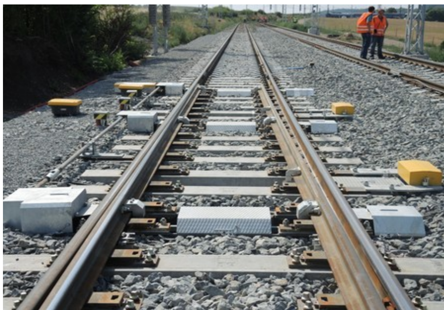
Obr. č. 4: Výhybka č. 29X přestavená do odbočného (vedlejšího) směru. V pozadí vpravo je vidět místo srážky vlaků. Zdroj: DI
