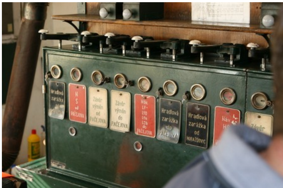
Obr. č. 17: Polohy clonek na hradlové skříni na St. 2
