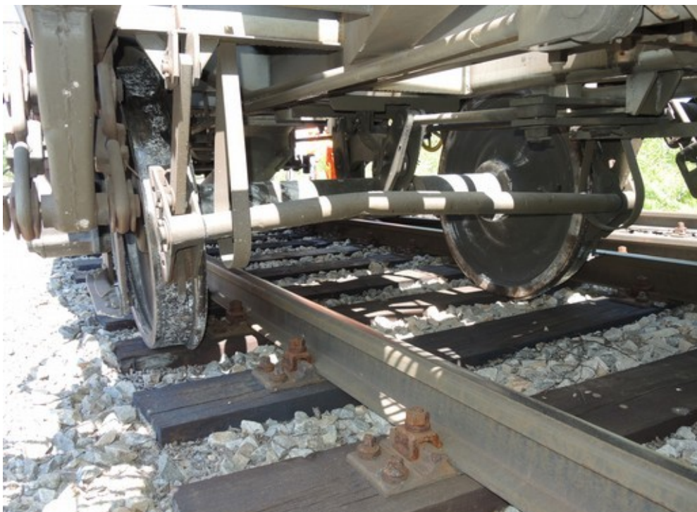
Obr. č. 3: Detail vykolejeného dvojkolí s vysvléknutou obručí (vlevo) a poškození spodku a brzd DV u 1. nápravy od betonového panelu
