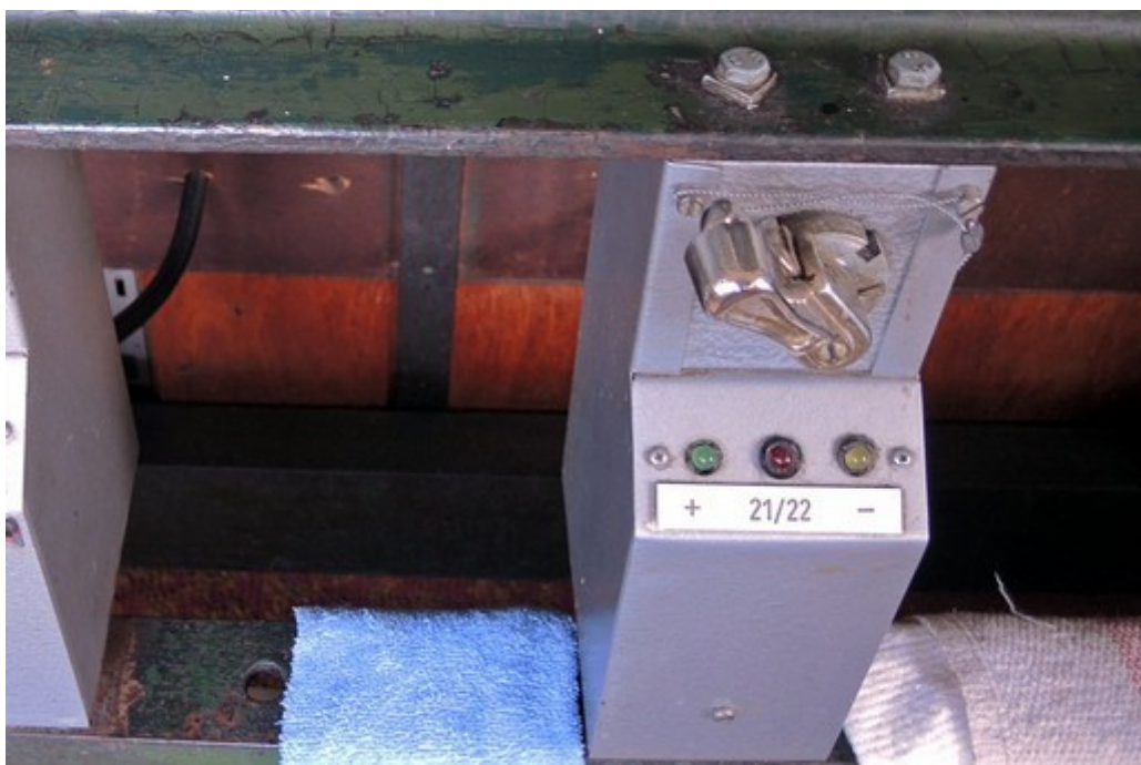
Obr. č. 4: Manipulátor dvojice výhybek č. 21/22 bez potvrzení polohy koncové polohy „plus“ indikačním světlem (zelená LED dioda)
