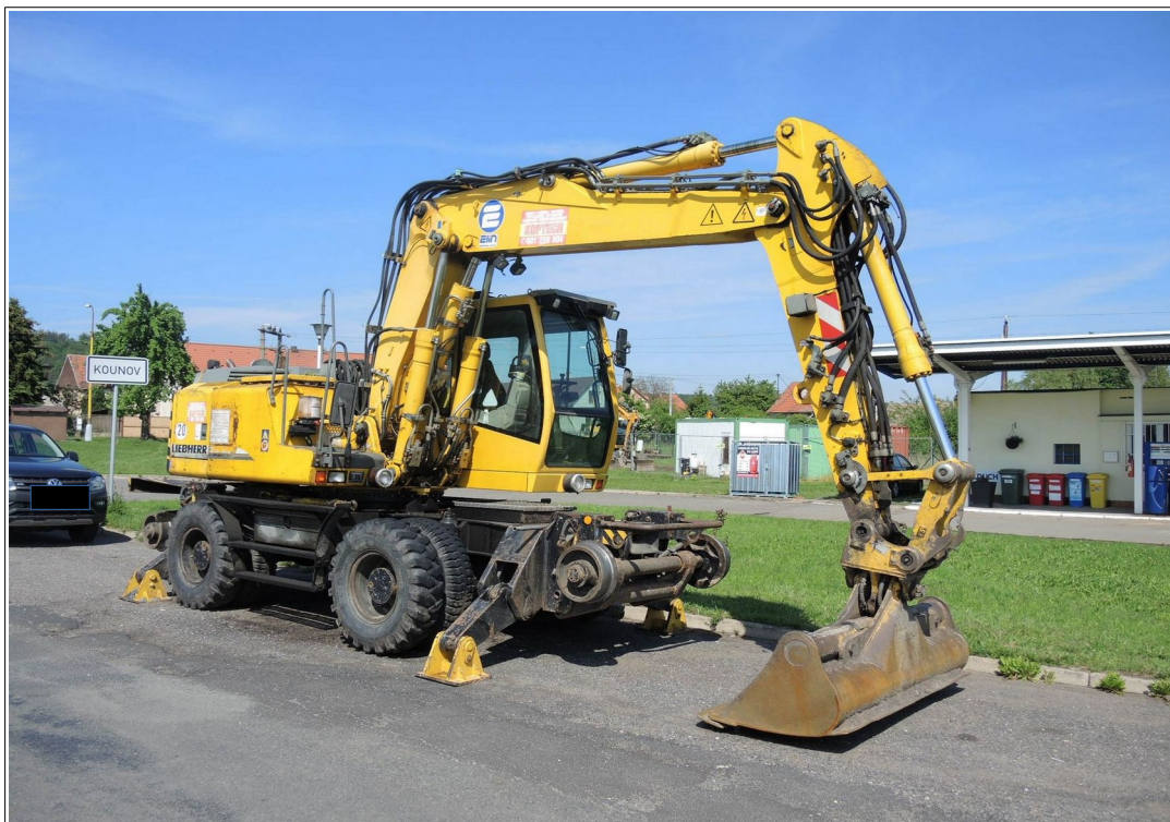
Obr. č. 11: Dvoucestné rypadlo, kterým byl nakládán vytěžený materiál na předmětný vůz č. 83 54 9200 794-2 v zast. Kounov
