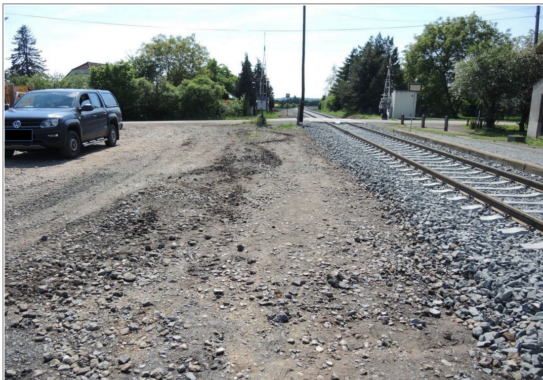
Obr. č. 10: pohled na místo nakládky vytěženého materiálu na předmětný vůz č. 83 54 9200 794-2 v zast. Kounov (vpravo nástupiště, v pozadí předmětný ŽP P2342)
