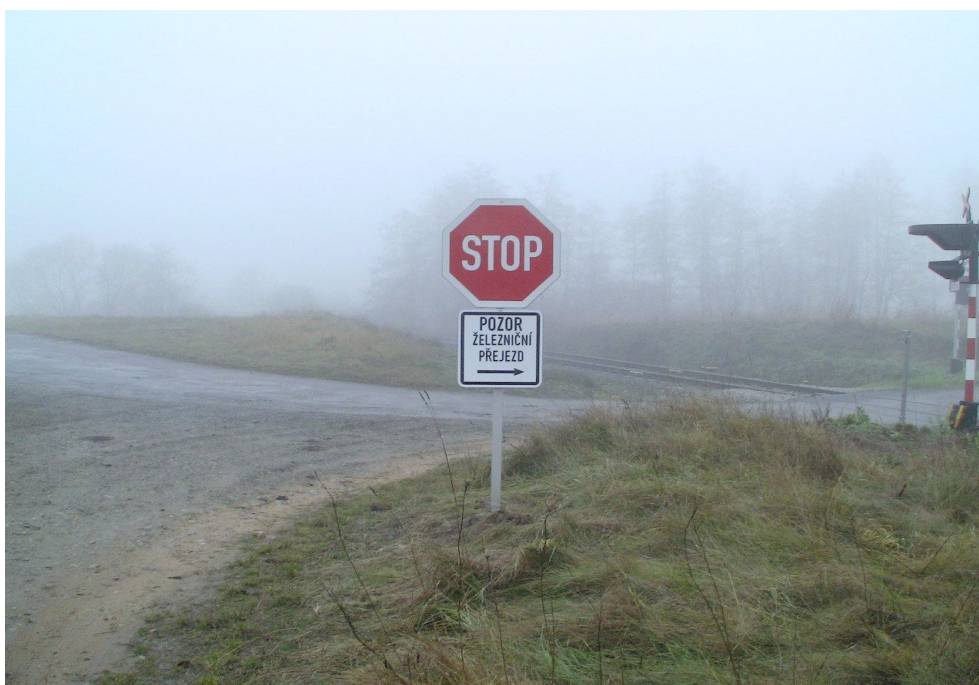
Obr. č. 8: Přijaté opatření k zajištění bezpečnosti (nové dopravní značení na výjezdu z polní cesty)
