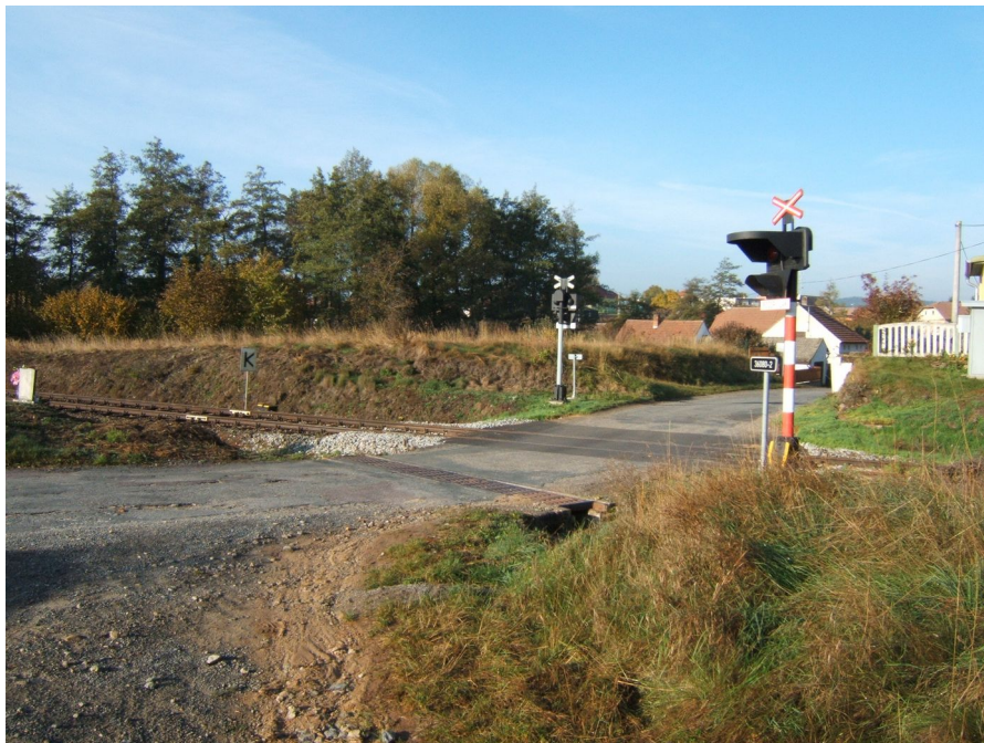
Obr. č. 3: Viditelnost výstražného kříže (na 15 m) Zdroj: DI
