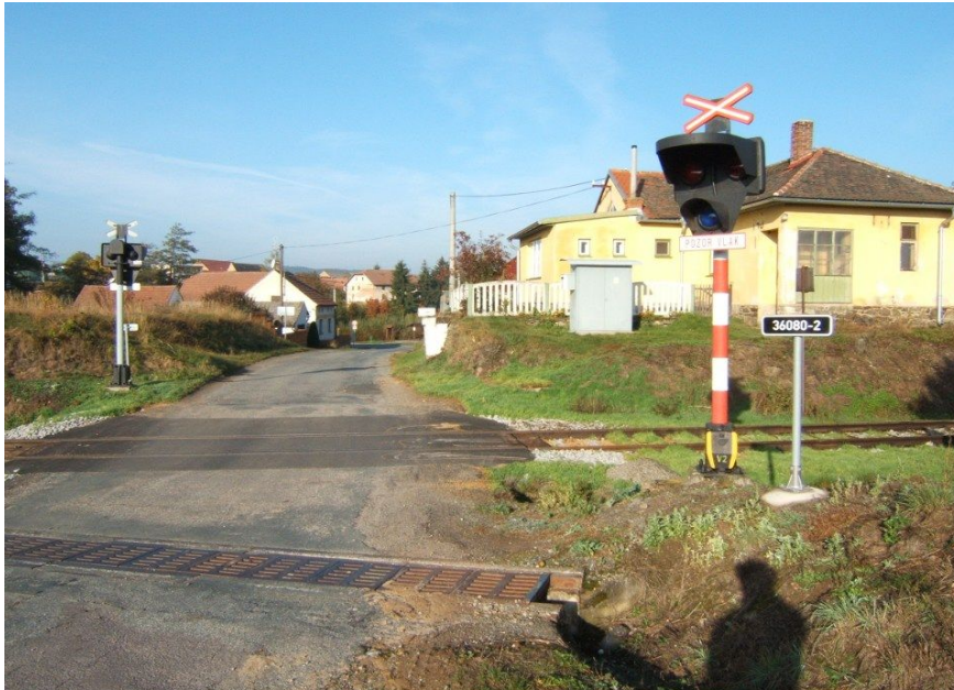
Obr. č. 4: Viditelnost čela výstražníku (na 7,5 m) Zdroj: DI
