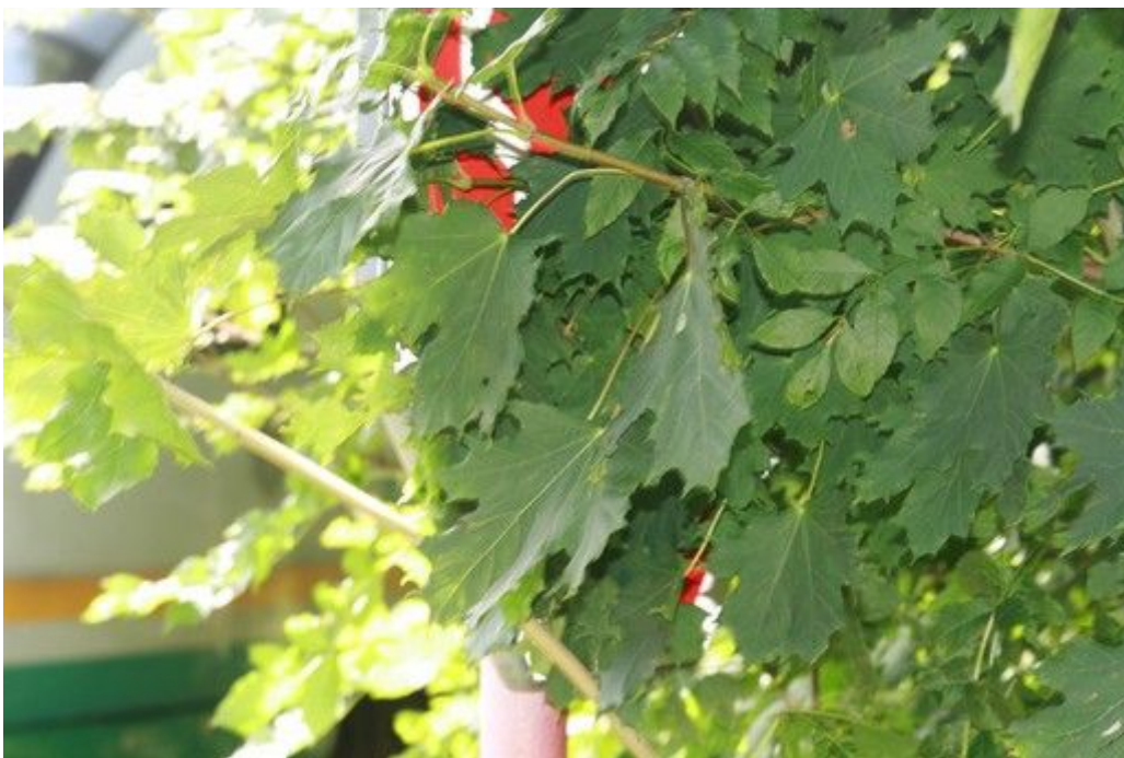
Obr. č. 7: Zarostlé dopravní značení přejezdu ve směru od obytného stavení (nevyhovující Lp a Dz)
