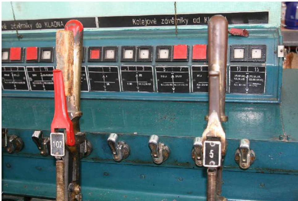
Obrázek 7: kolejový číselník výhybkářského přístroje stavědla 1, stav během šetření MU
