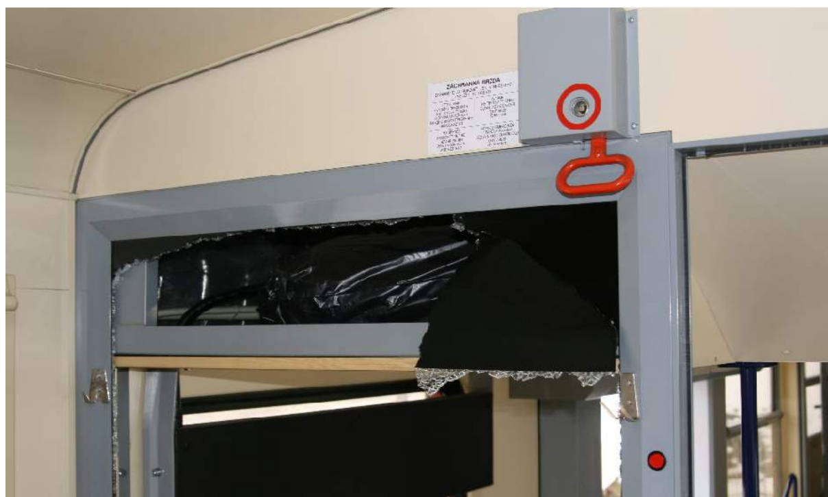
obrázek 18: levá polovina přičky, pohled z uzavřeného oddílu
