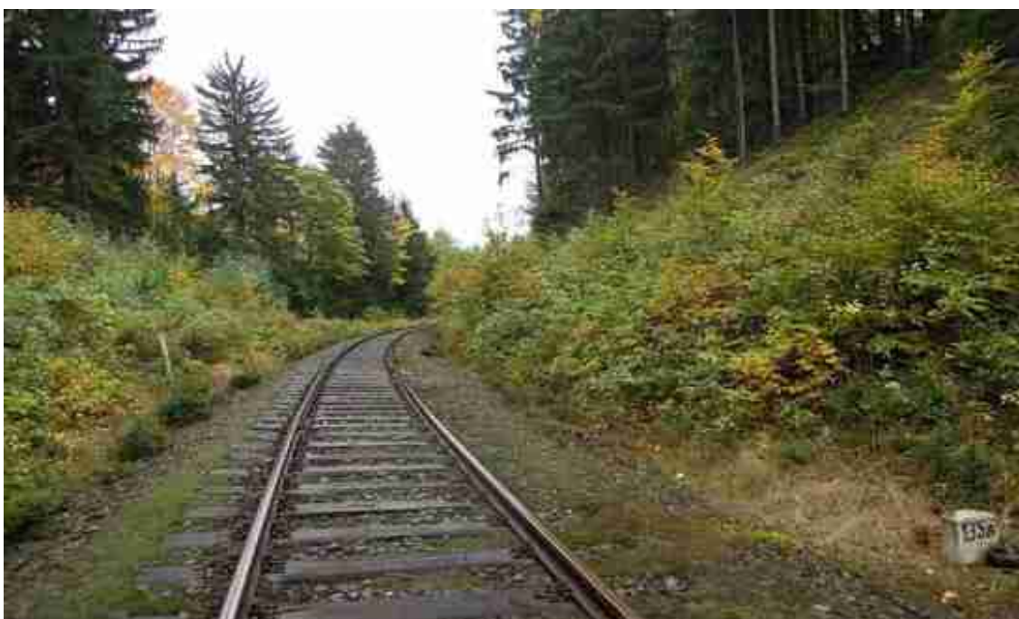
Obr. č. 11: Pohled od označníku na kolej směr místo MU, jež není vidět. Zdroj: Drážní inspekce
