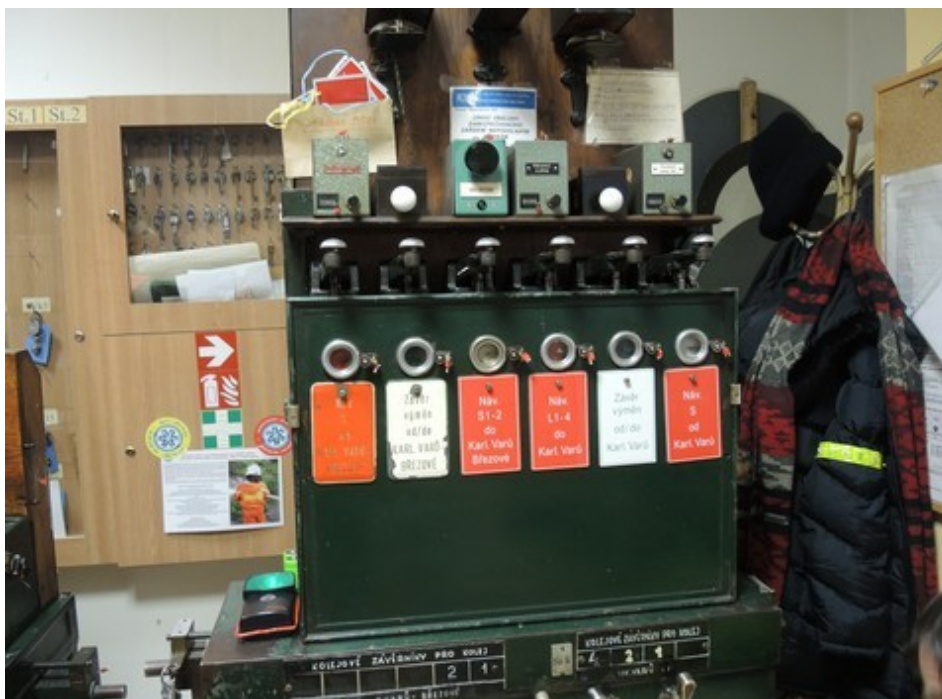
Obr. č. 5: Pohled na řídicí přístroj elektromechanického SZZ v dopravní kanceláři žst. Karlovy Vary dolní nádraží
