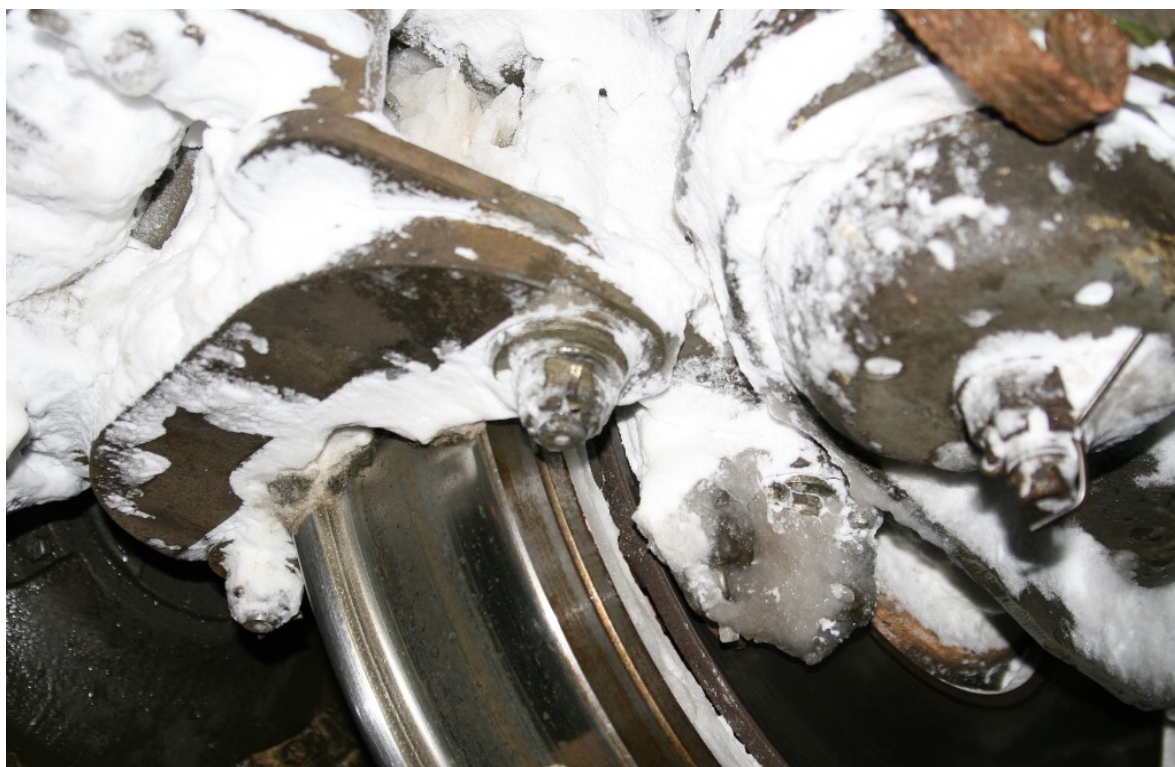
Foto č. 3: Pohled z montážního kanálu na brzdový kotouč HDV 843 004-3 po stažení z místa MU dne 16. 02. 2012 do PJ Liberec.
