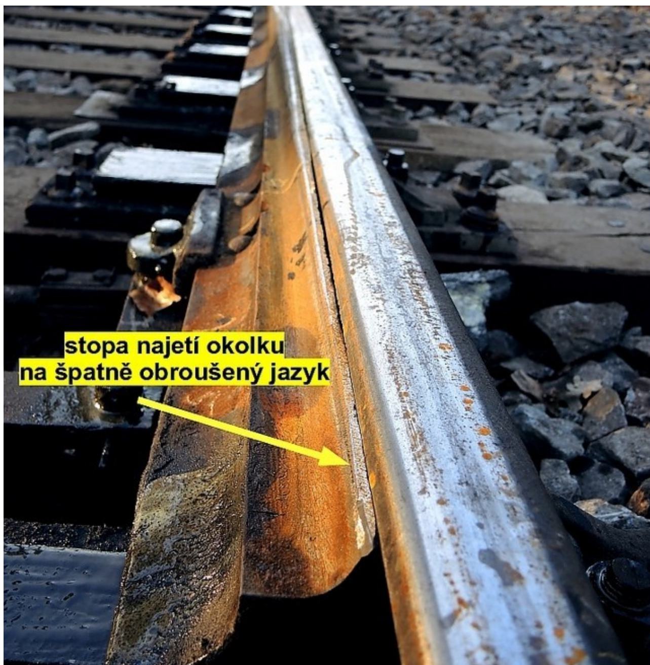
Obr. č. 11: Příliš obroušený pravý jazyk a viditelná stopa po vyšplhání okolku kola na něj
