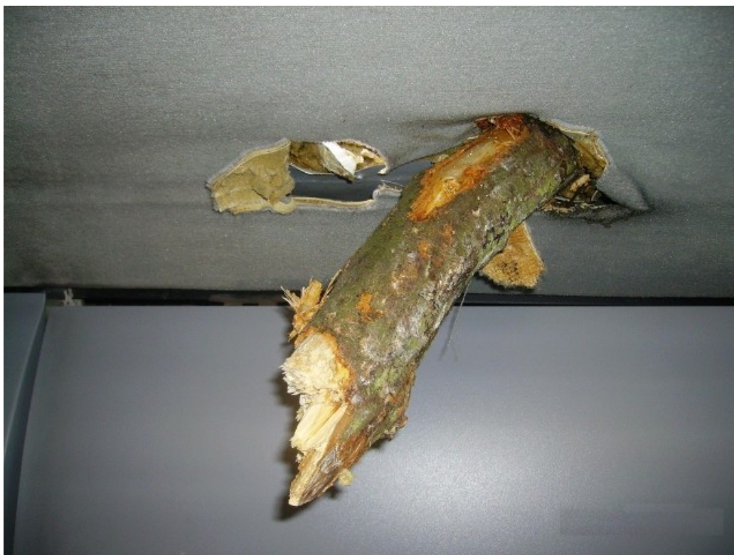
Foto 3: Poškozená střecha motorové jednotky
