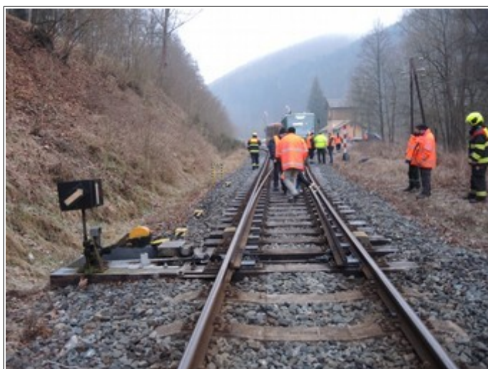
Obr. č. 5: Výhybka č. 1sv
