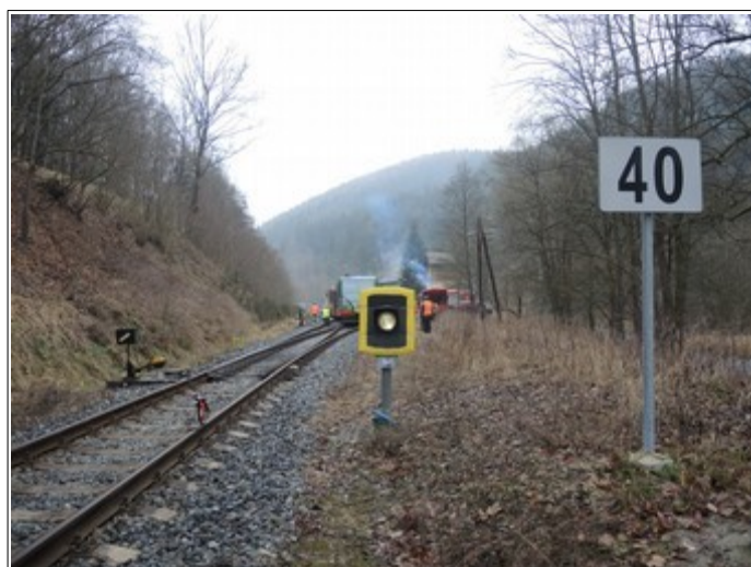
Obr. č. 6: Návěst „Jízda zajištěna“
