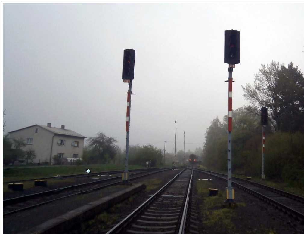
Obr. č. 1: Pohled na místo MU, hlavní (odjezdové) návěstidlo S1 žst. Kunovice-Loučka
