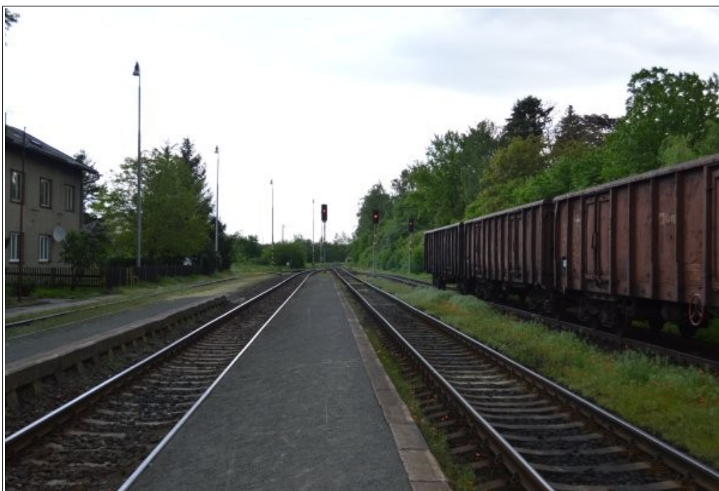
Obr. č. 5: pohled na odjezdová návěstidla S1 až S3 na braneckém zhlaví žst. Kunovice-Loučka z prostoru určeného pro výstup a nástup cestujících
