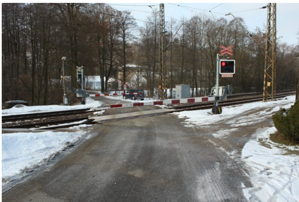
Obr. č. 10: Přejezd P3696 u zastávky Sázavka
