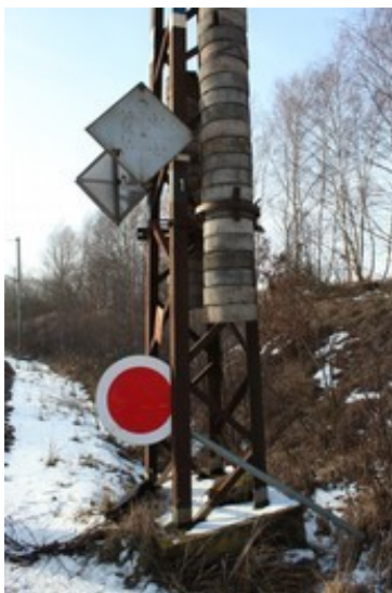
Obr. č. 6: Pohled na přenosné návěstidlo „Stůj“ pokusně nainstalované DI na záhlaví žst. Leština
