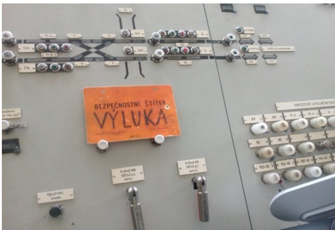
Obr. č. 1: Pohled na reléový pult v žst. Leština u Světlé
