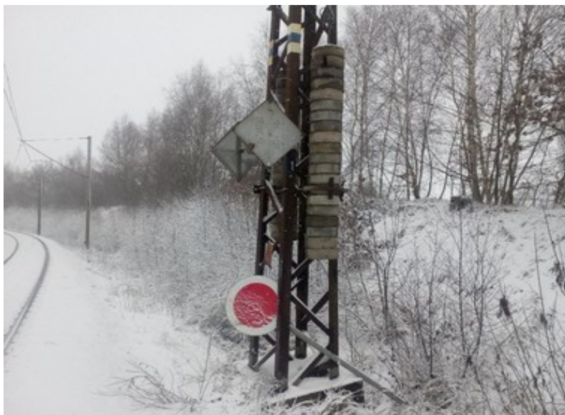
Obr. č. 5: Pohled na přenosné návěstidlo „Stůj“ na záhlaví žst. Leština v době vzniku MU Zdroj: SŽDC
