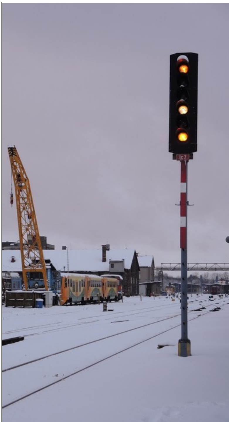
Obr. č. 3: Pohled na cestové návěstidlo Lc2 žst. Liberec situované v km 159,825 vpravo přímo u SK č. 102.
