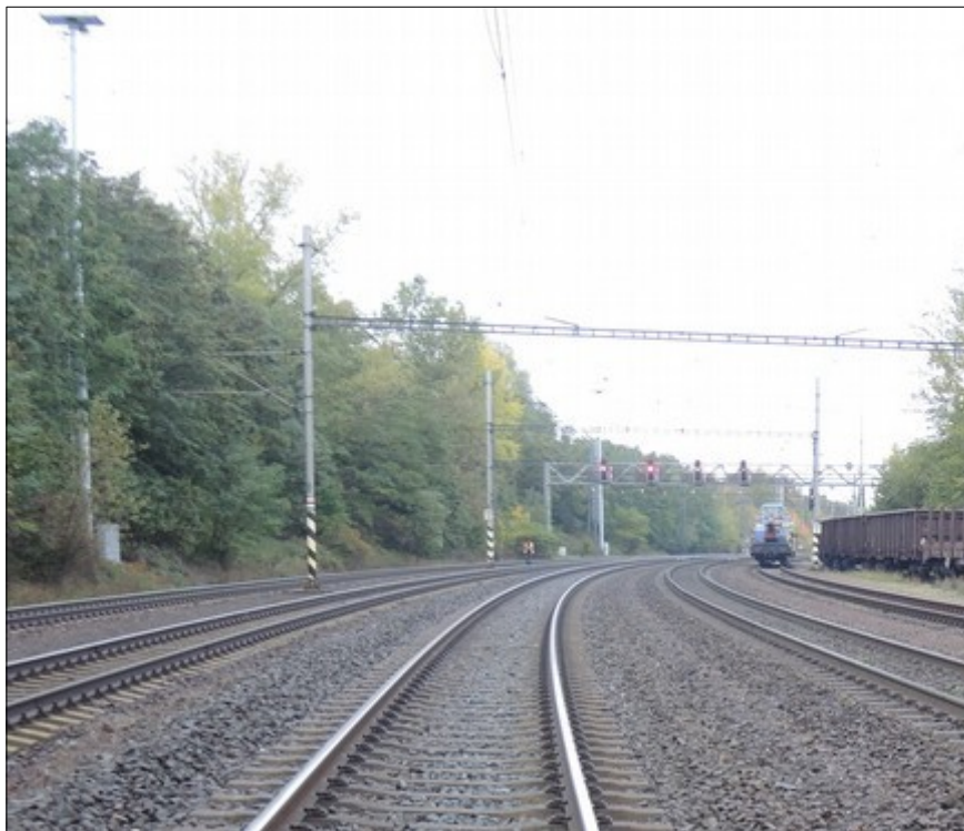
Obr. č. 3: Pohled na hlavní (odjezdové) návěstidla umístěné na návěstní lávce žst. Lipník n/B.
