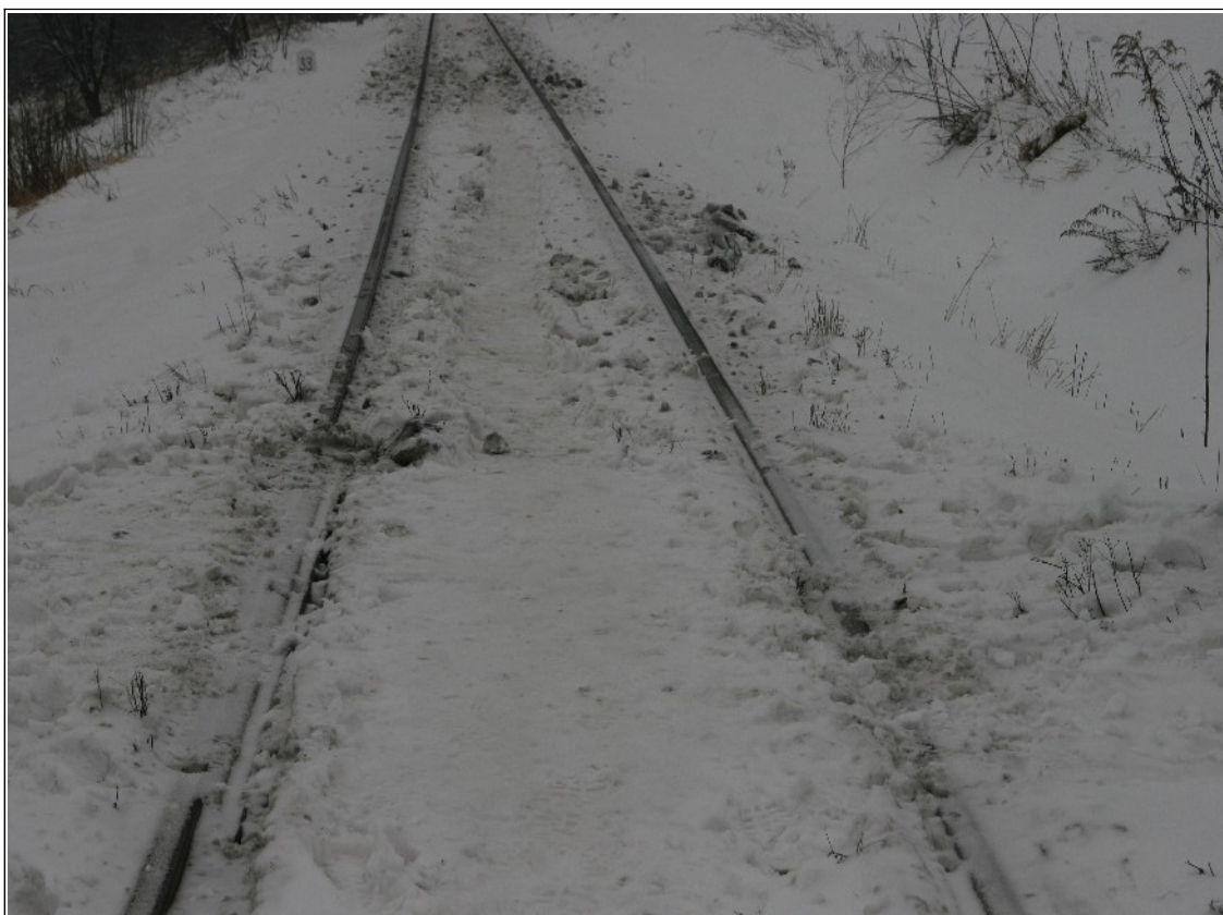
Foto 1: pohled na ŽP v km 33,044 (P4299), kde ve směru jízdy vlaku R 900 levé kolo 3. nápravy TDV řady B, č. 50 54 20 41 408-6, v km 33,046, okolkem narazilo do hrany zaklopené kolejnice tvořící žlábek ŽP.
