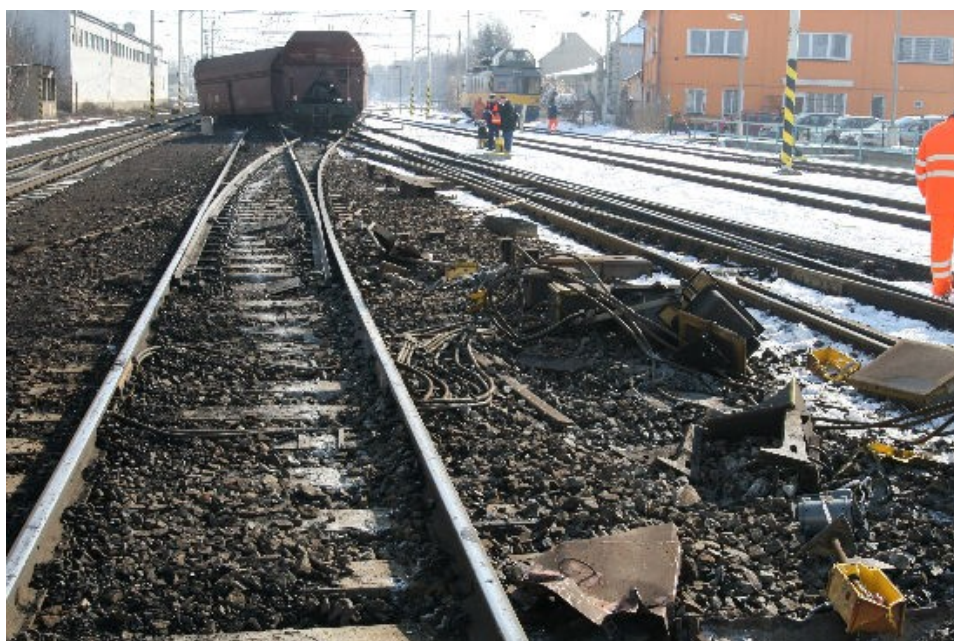
Foto 4: pohled na konec vlaku a zničené vnější prvky SZZ
