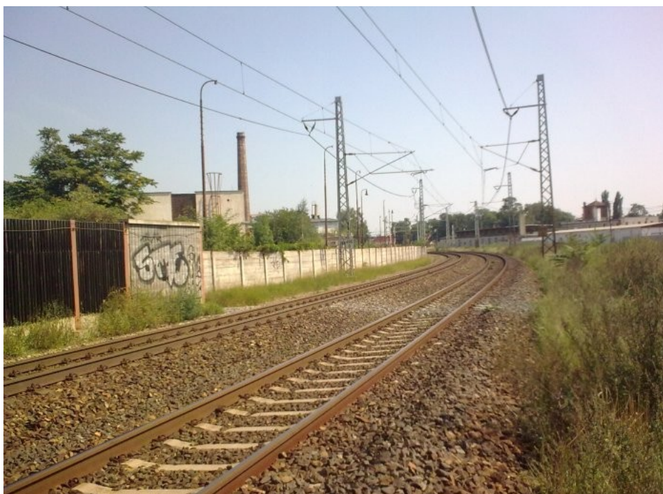
Foto č. 9: Pohled na trať ve směru žst. Lovosice
