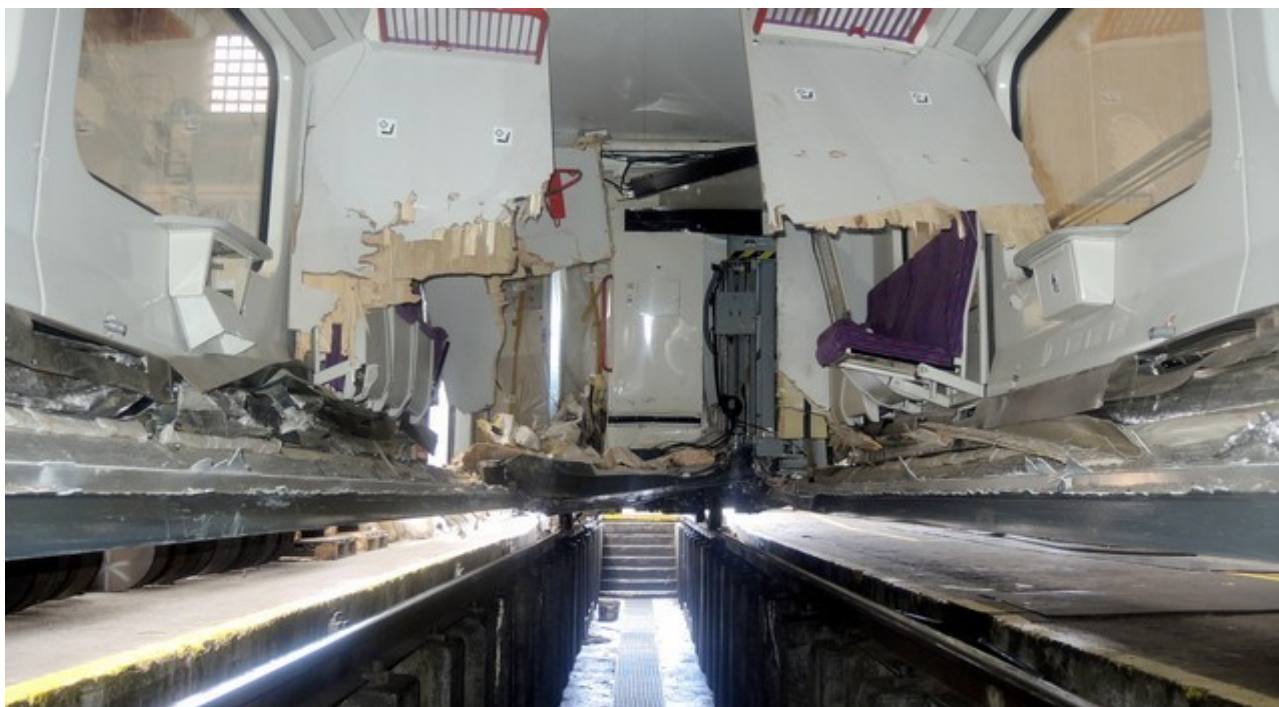
Obr. č. 23: Vlivem jízdy HDV po troskách zarážedla došlo k poškození podlahy a interiéru v dolní části HDV. Při odklízovacích pracích byly poškozené části odstraněny z důvodu umožnění odtahu dotčené vlakové soupravy.
