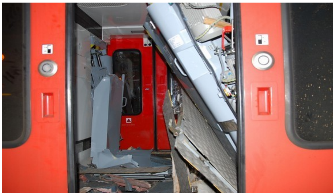
Obr. č. 22: Vlivem jízdy HDV po troskách zarážedla došlo mj. k odtržení zvedací plošiny pro cestující se sníženou schopností pohybu. Zdroj: SŽDC
