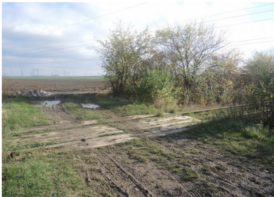
Obr. č. 6: Chybějící označení železničního přejezdu v km 0,520 výstražnými kříži
