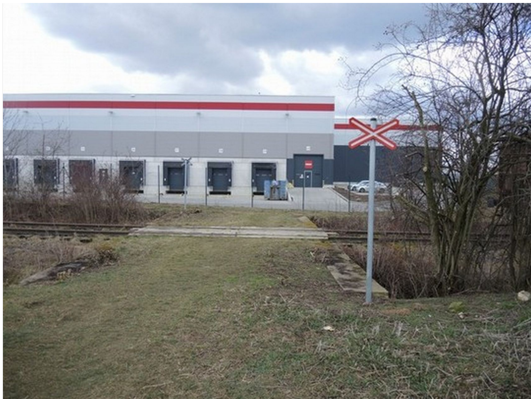
Obr. č. 13: Doplněný výstražný kříž na jednom z železničních přejezdů na vlečkové manipulační koleji č. 1 Zdroj: DI
