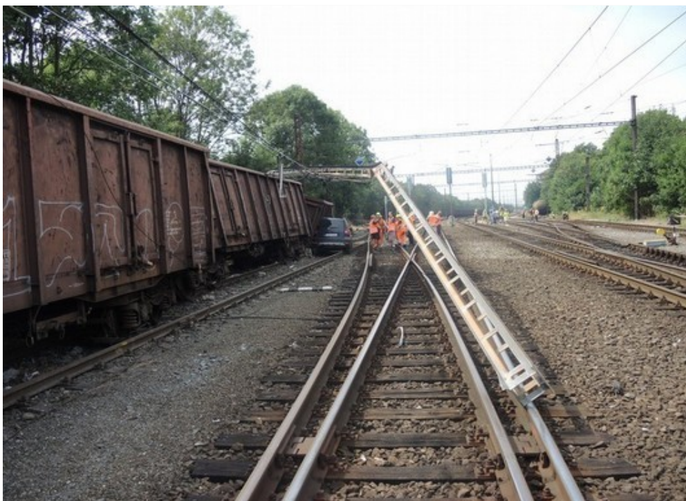
Obr. č. 3: Pohled na poškozené trakční vedení, vykolejená DV a poškozený osobní automobil Zdroj: DI
