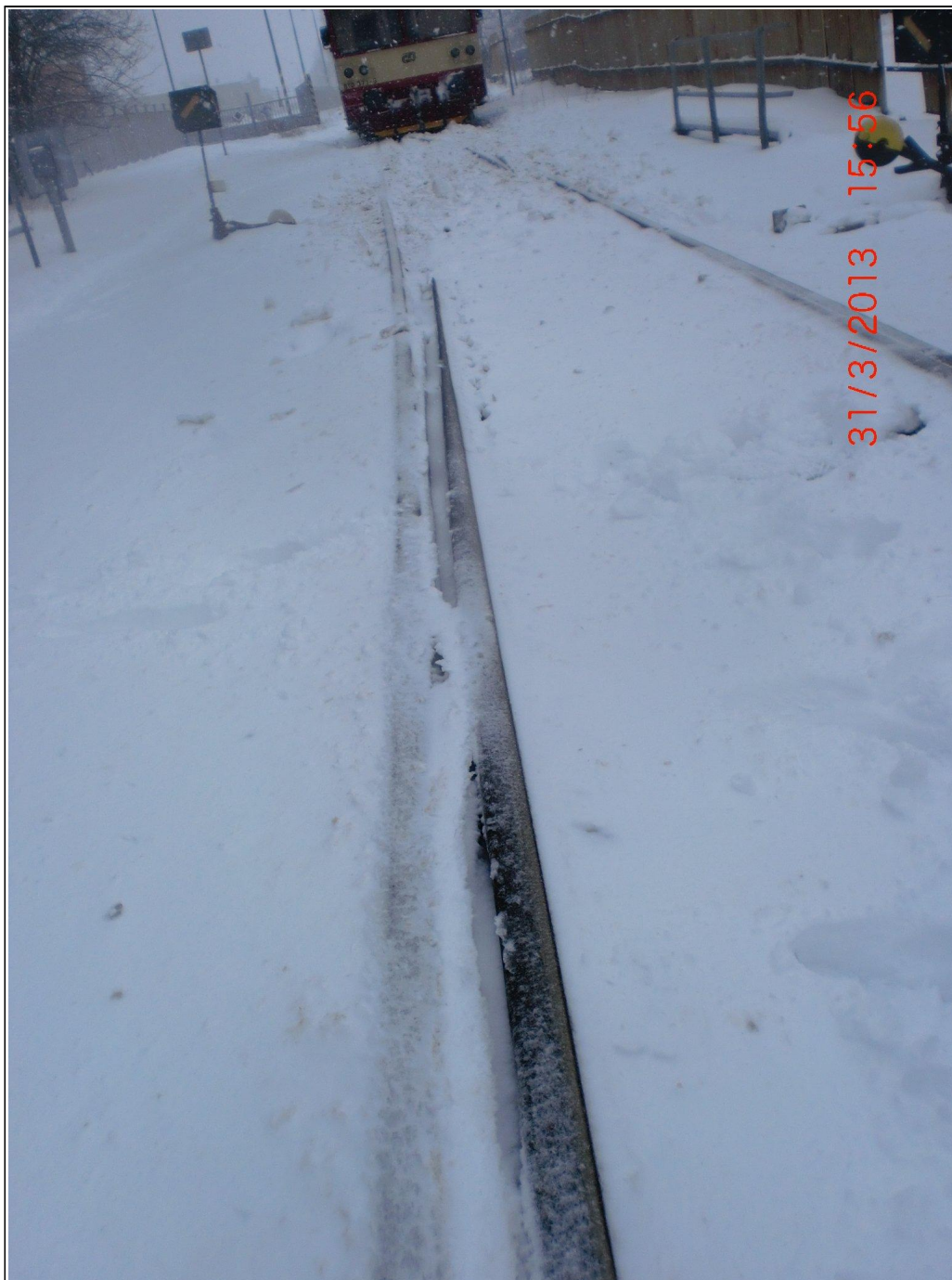
Obr. č. 3: Pohled na zasněžený pravý rovný odlehlý jazyk a pravou ohnutou opornici výhybky č. 7sv přestavené do preferovaného směru na kolej č.1 v dopravně D3 Odry
