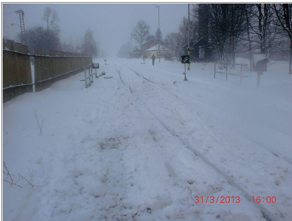
Obr. č. 4: Pohled směrem od vykolejeného vlaku Os 13310 do dopravní D3 Odry a na výhybku č. 8 a č. 7sv opatřenou samovratným přestavítkem
