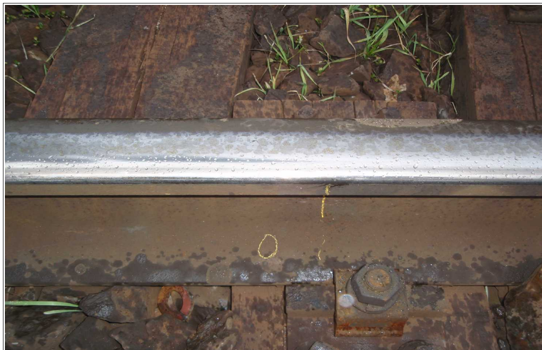
Obr 7.2: Bod „0“ první stopa vykolejení 8. TDV za HDV vlaku Pn 59630
