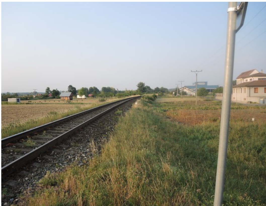
Obr. č. 3 : Výhled řidiče OA ve směru příjezdějího vlaku
