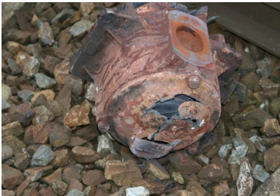
Obr. č. 7: Ložisková skříň na místě vykolejení
