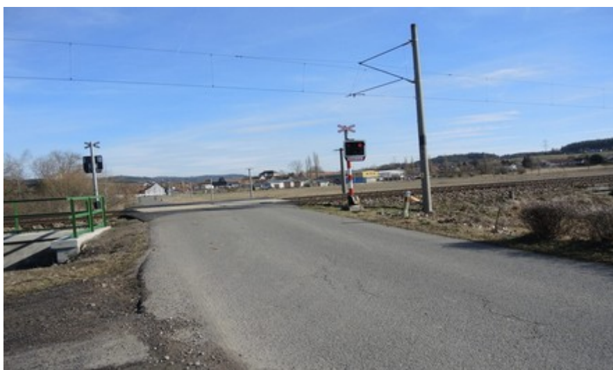
Obr. č. 4: Viditelnost výstražníku, délka rozhledu pro řidiče kolového traktoru z polní cesty
