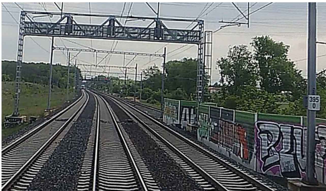
Obr. č. 7: Pohled na situaci na trati v km 395,0 (návěstidlo S0a je vzdáleno 408 m), kdy vlevo je kolej č. 2a, uprostřed je kolej č. 0a, vpravo je kolej č. 1a a v prostoru za protihlukovou stěnou je poté kolej č. 101a. Návěstidla (Lc1a, Lc0a a Lc2a, platící pro opačný směr) na návěstní lávce jsou pouze tři. Zdroj: DI
