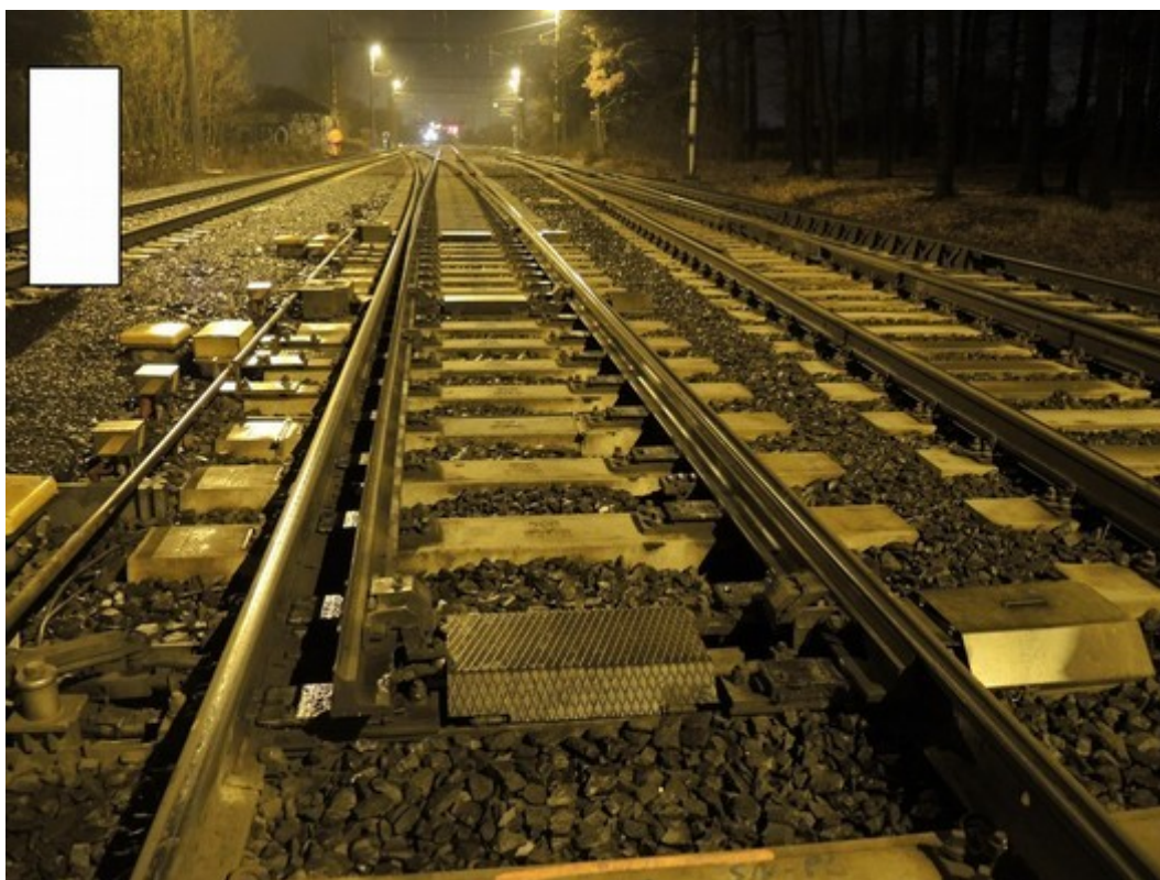
Obr. č. 5: Pohled na výhybku č. 6 v době ohledání DI (v zadní části fotografie je vidět čelo vlaku Ex 285)
