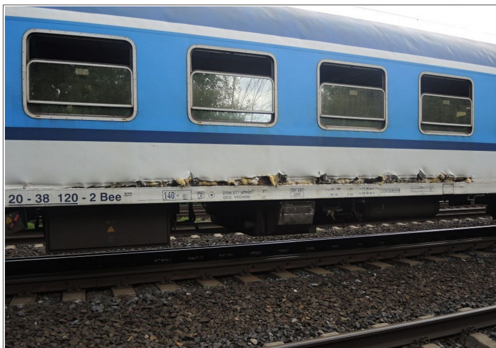
Obr. č. 6: Poškozené opláštění bočnice jednoho z vozů R 989
