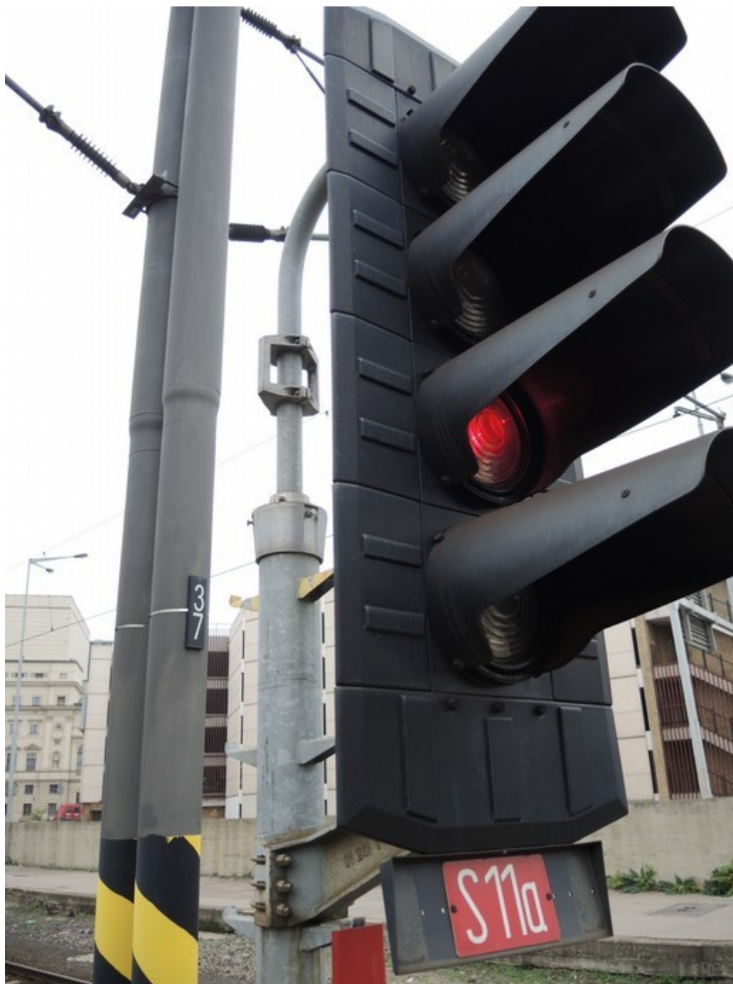
Obr. č. 10: Viditelnost odjezdového návěstidla S11a ze vzdálenosti 1 m, z pozice strojvedoucího mírně vykloněného z bočního okna stanoviště HDV Zdroj: Drážní inspekce
