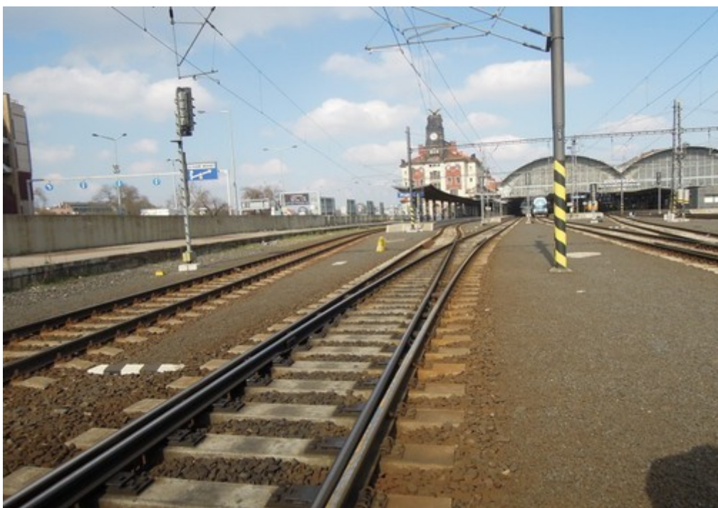
Obr. č. 3: SK 11a (druhá zleva) pohled od vinohradského tunelu Zdroj: Dražní inspekce
