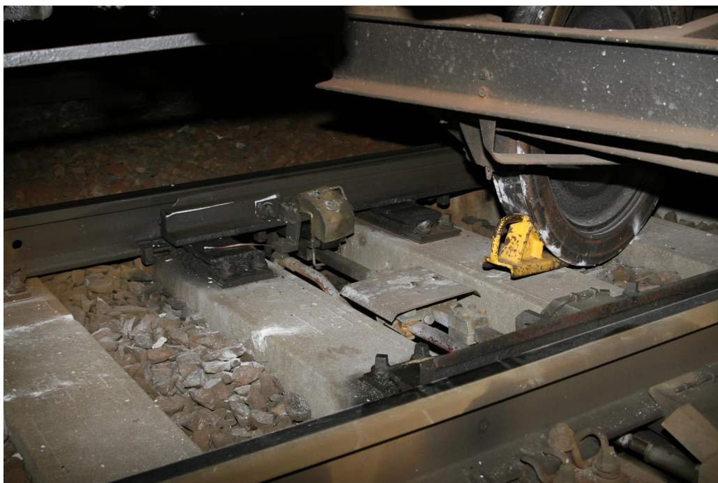
Obr. č. 4: Vykolejený podvozek a poškození jazyka výhybky Zdroj: DI
