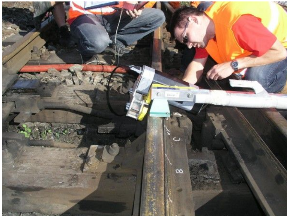
Foto 4: Snímek dokumentující měření příčných profilů hlavy opornice a jazyka výhybky č. 208ab, části „a“ v bodě „0“
