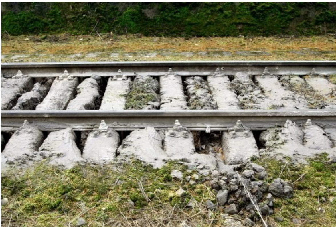
Obr. č. 11: Detail stavu blátivého místa dne 14. 11. 2014
