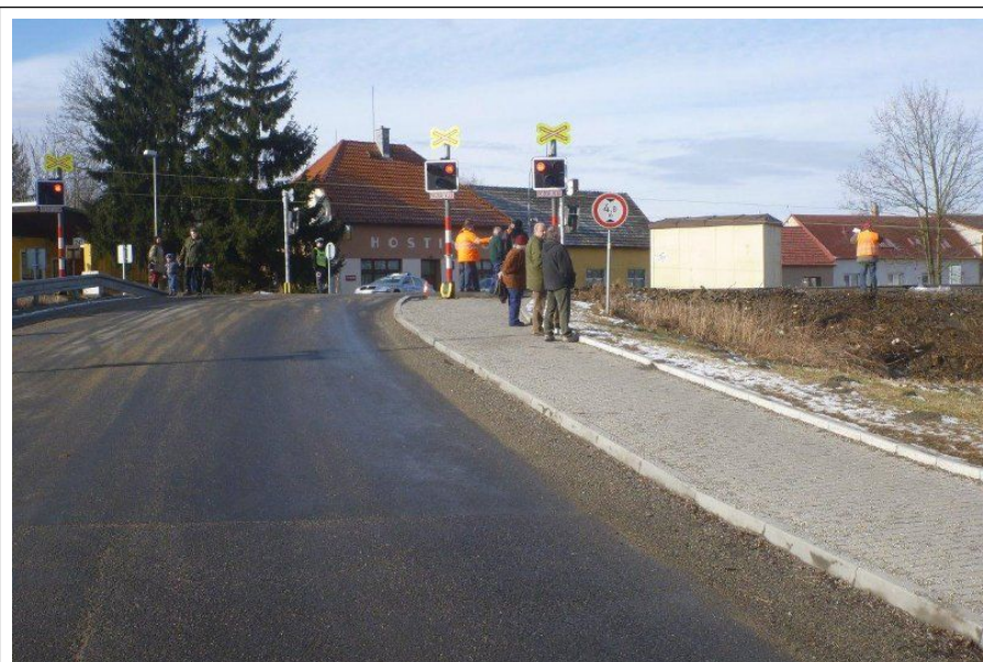
Foto 3: Pohled na železniční přejezd P 1148
