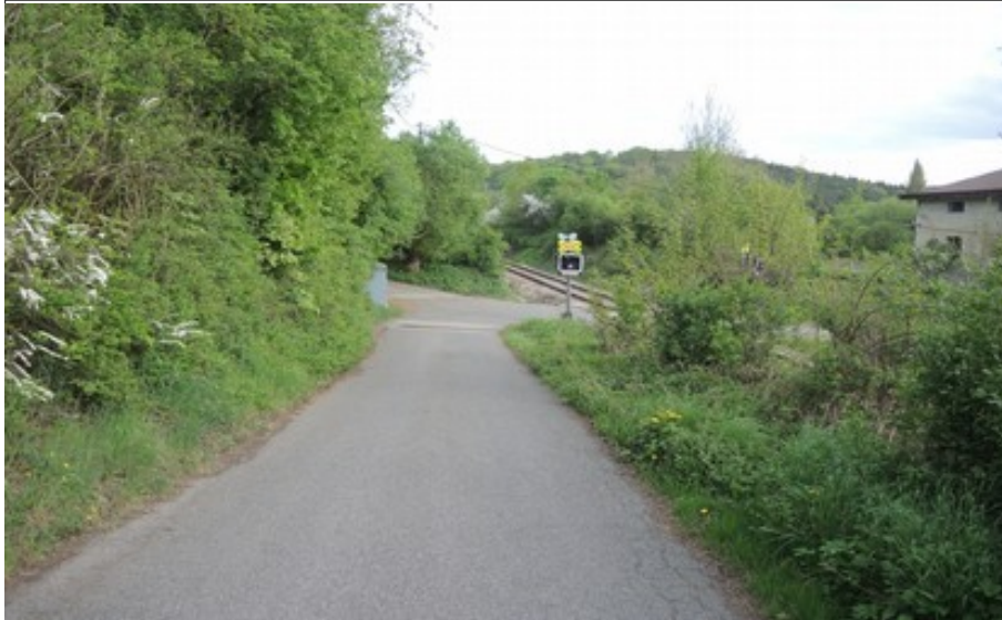
Obr. č. 3: Dz ve směru jízdy OA
