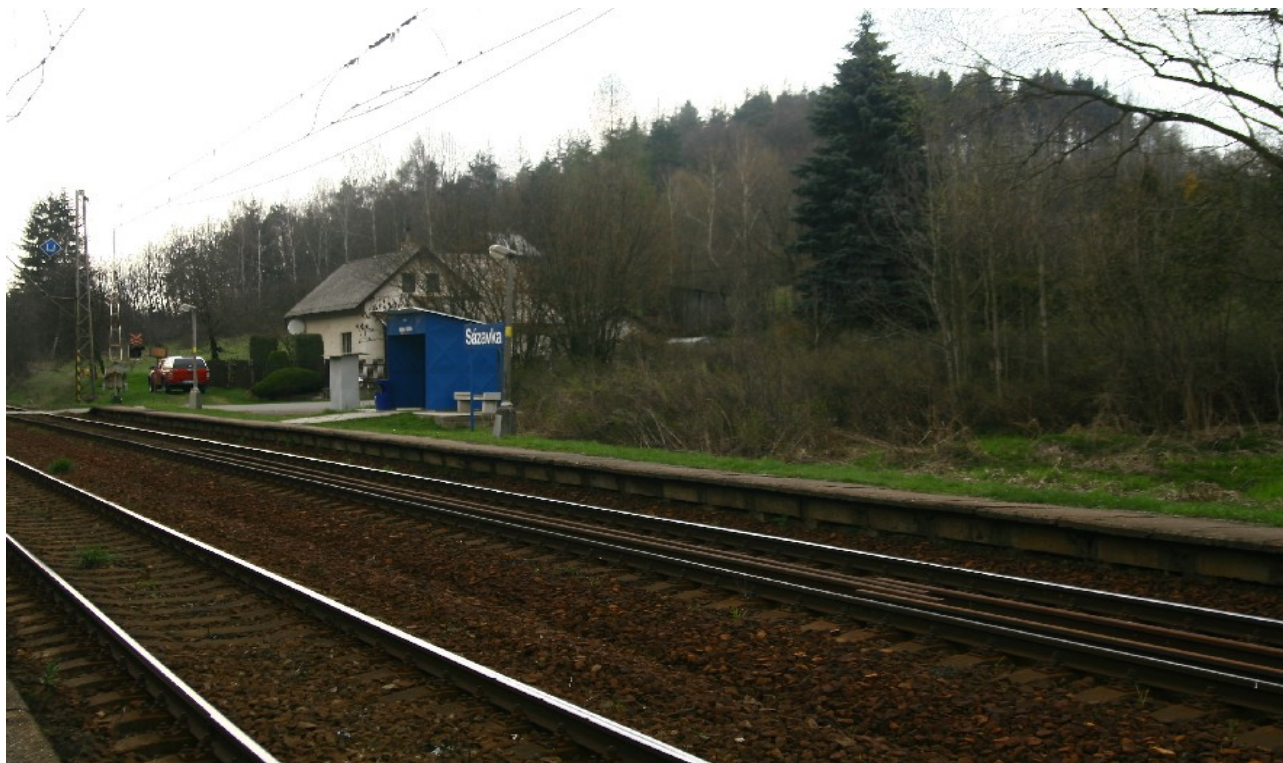
Foto 1: Nástupiště u 2. TK na zastávce Sázavka
