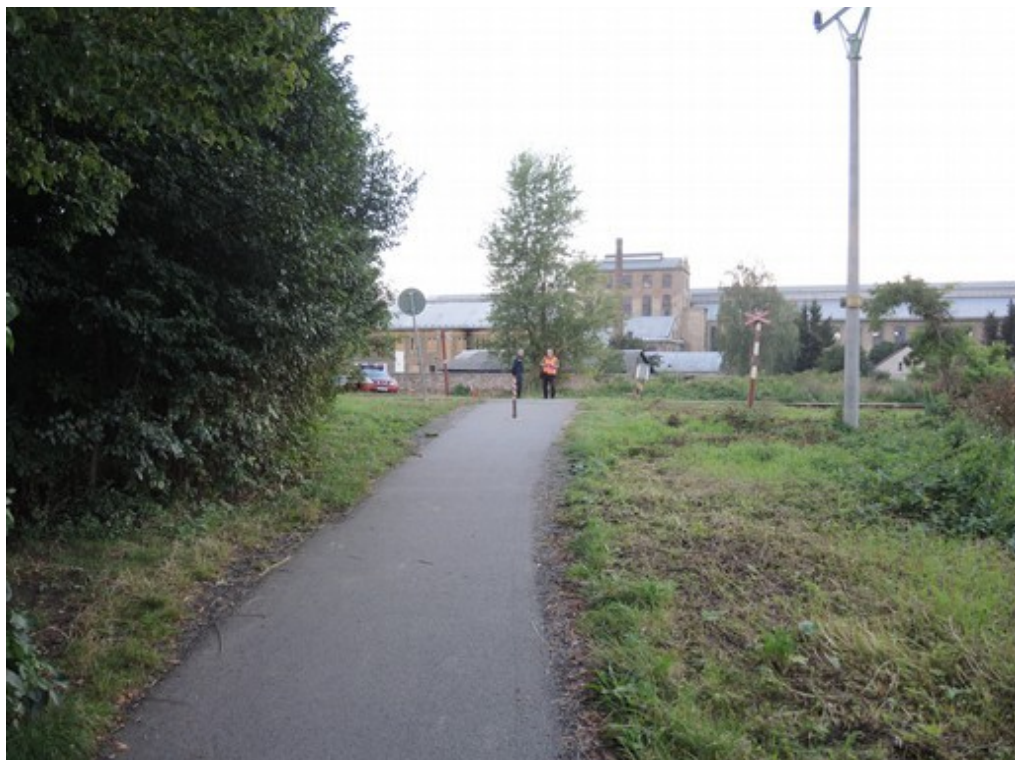
Obr. č. 3: Zhoršená rozhledová délka L_r (vlevo) ze směru od Chrudimi z pohledu cyklisty
