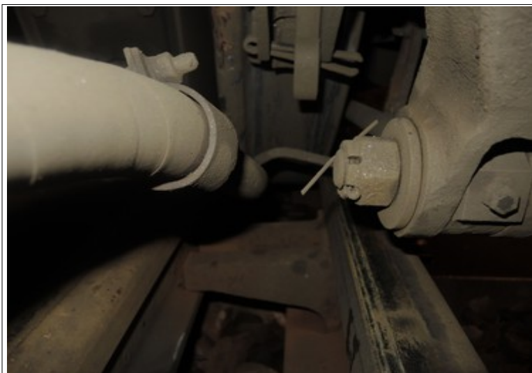
Obr. č. 3: Vykolejené kolo 1. nápravy zadního podvozku Zdroj: DI
