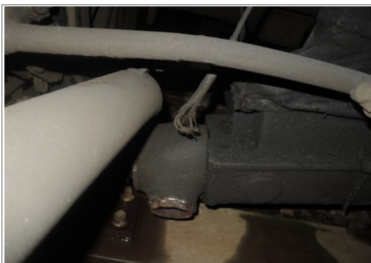
Obr. č. 4: Ulomená šikmá tyč a přetržené záchytné lano
