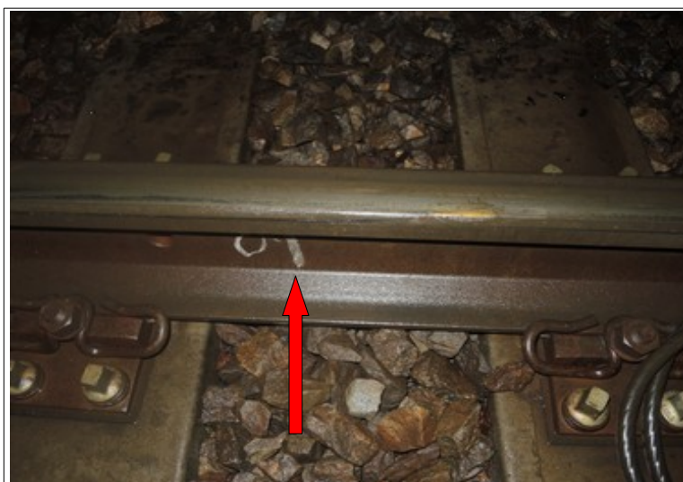
Obr. č. 5: Bod „0“ v km 272,794
