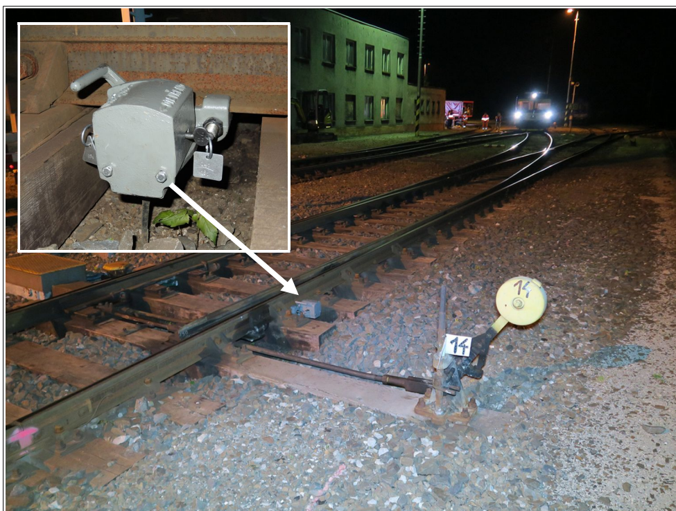
Obr. č. 7: Celkový pohled na místo MU ze směru od začátku výhybky č. 14. Snímek ve výřezu dokumentuje kontrolní odtlačný zámek, osazený na pravé přímé opornici, se dvěma vloženými klíči.
