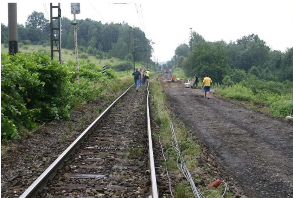
Foto 1: Pohled na 1. traťovou kolej ze směru od vykolejení vlaku
