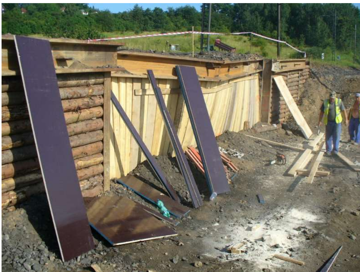
Foto 5: Stavební práce na železničním mostě po MU
