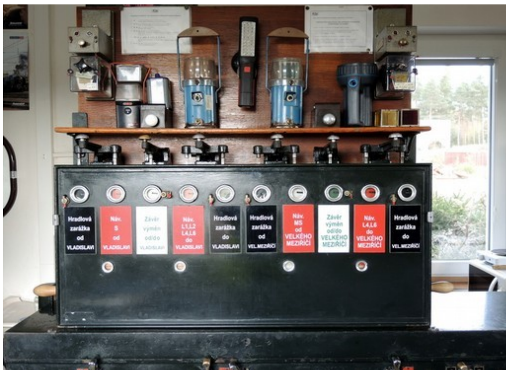
Obr. č. 6: Nasimulovaný stav stavědlového přístroje na St. 2 v okamžiku vzniku MU. Rozdíl proti obr. č. 4: „Závěr výměn od/do Velkého Meziříčí“ uzavřený – postavená vlaková cesta pro vjezd vlaku Os 24927
