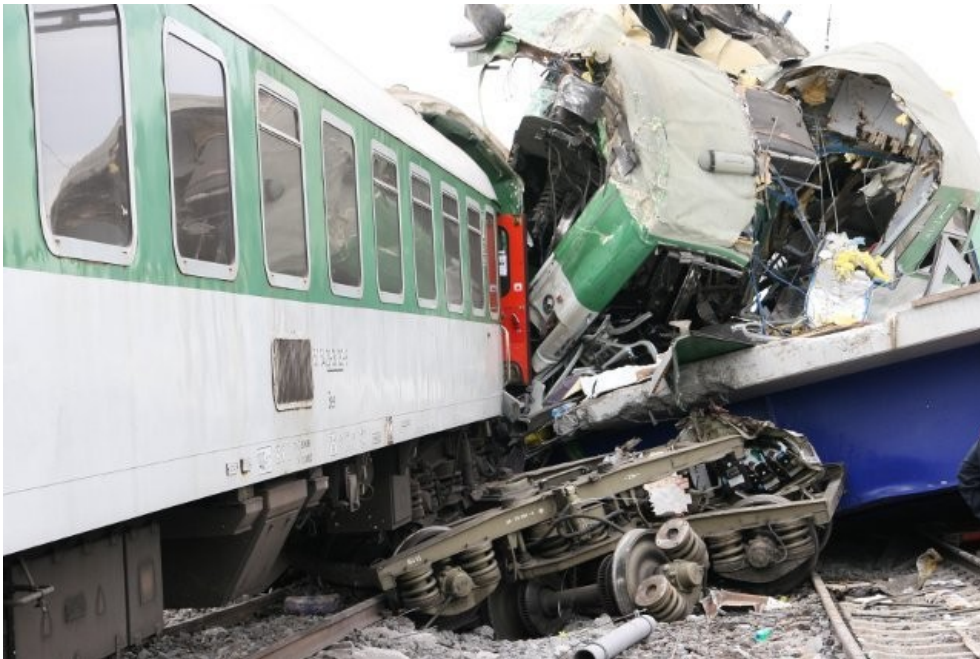
Obrázek 5: Detailní pohled na destrukci TDV vlaku EC 108, vzájemně zaklíněných o nosnou konstrukci zříceného mostu.
