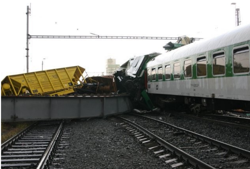
Obrázek 4: Pohled zleva ve směru jízdy vlaku EC 108 na TDV vlaku EC 108 a 1. nsł. Pn 60230, zaklíněná o nosnou konstrukci zříceného mostu.
