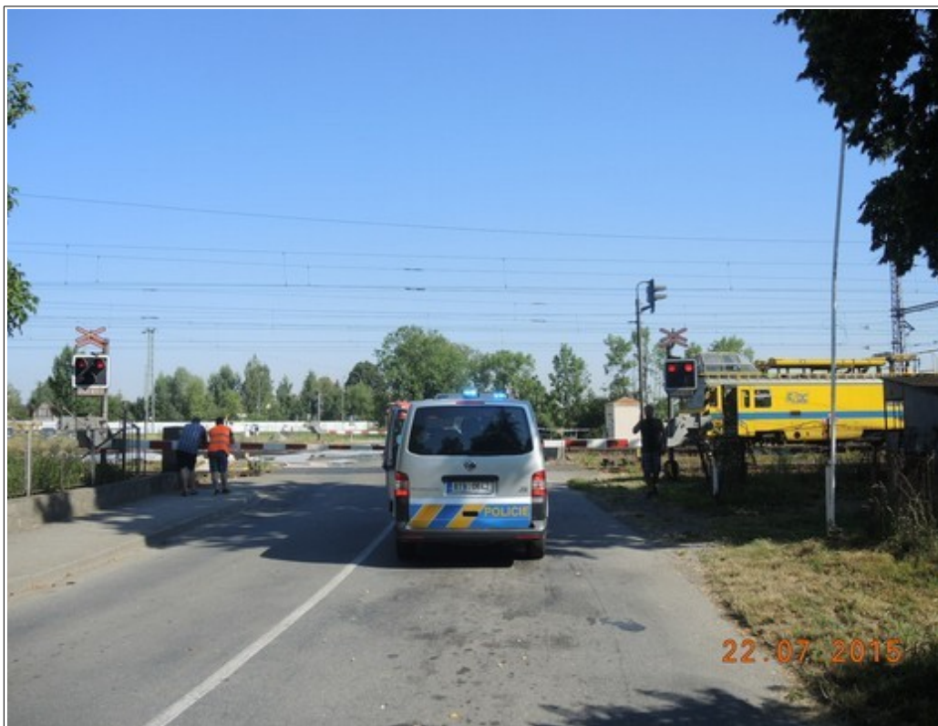
Obr. č. 5: Pohled na ŽP P6501 ve směru jízdy SMV.
