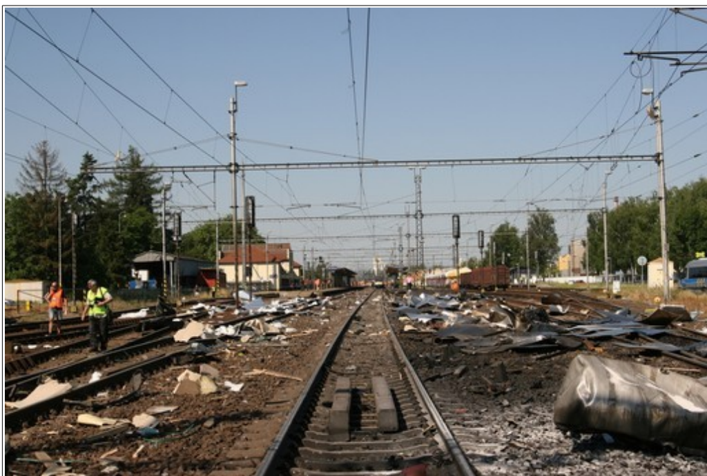
Obr. č. 9: Pohled na kolejiště žst. Studénka po střetnutí SMV s vlakem Ex 512. Zdroj: DI
