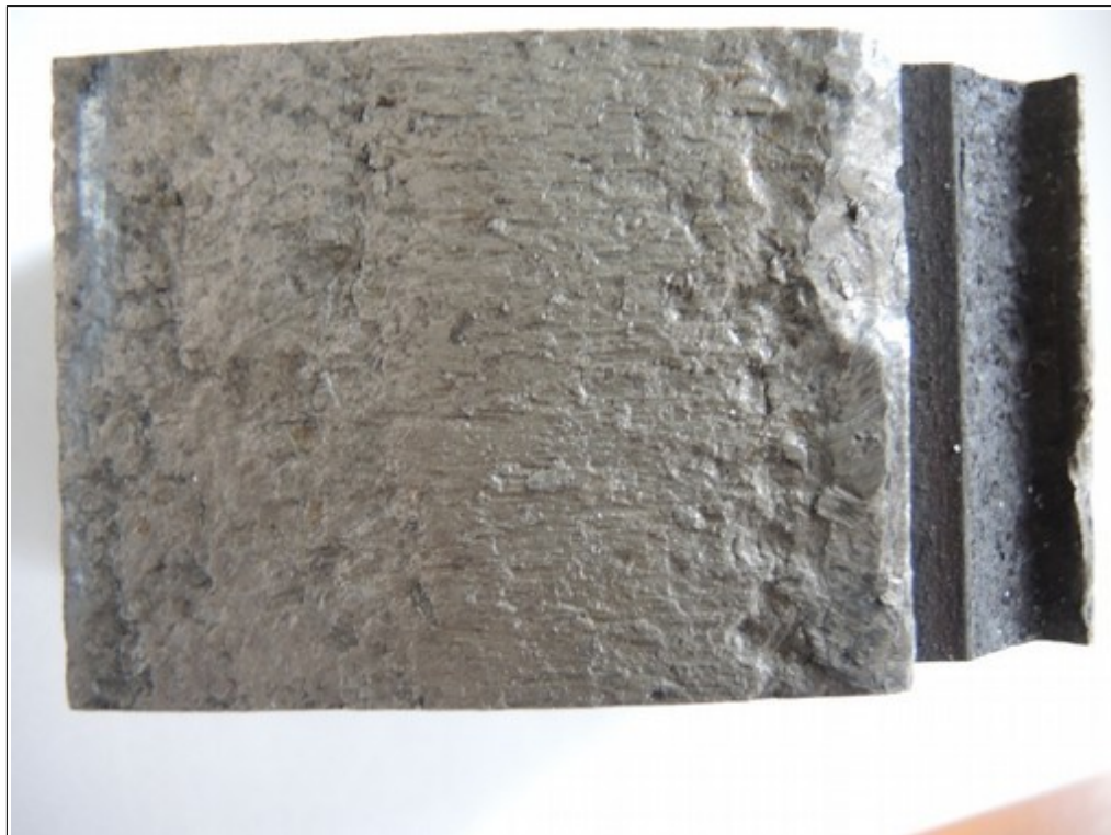
Obr. č. 9: Pohled na styčnou plochu poškozené obruče a vylomenou část obruče levého kola 1. nápravy TDV 88 54 9200 105-6.
